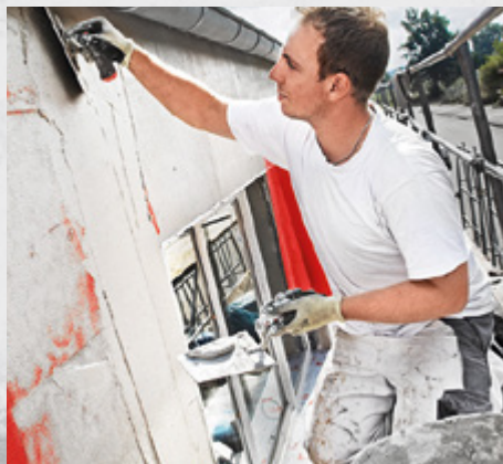
Omítání / zařízení budov a staveb / malířské a lakýrnické práce
